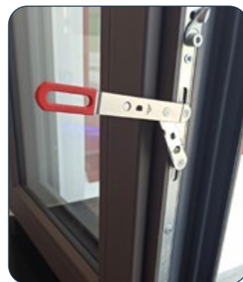
Páka štulpového křídla – OTEVŘENO
